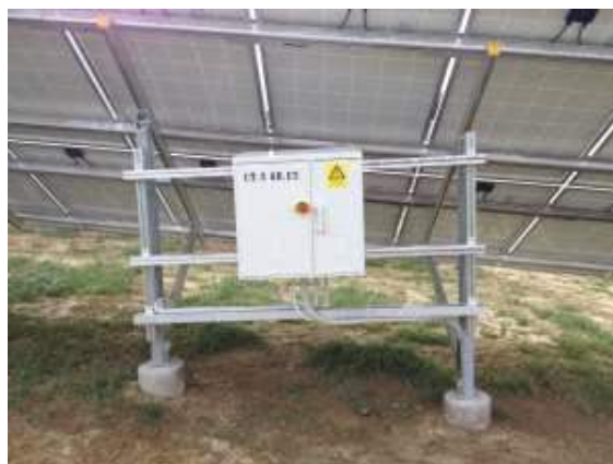
Slika 3, Slika 4: Pretvarači i SPMO ormar elektrane GR.E2
