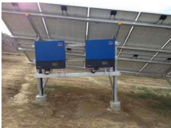
Slika 3, Slika 4: Pretvarači i SPMO ormar elektrane GR.E2
